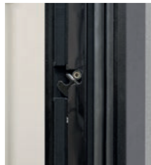
Der Verschluss mit pferdekopfförmiger Verriegelung im Rahmen
